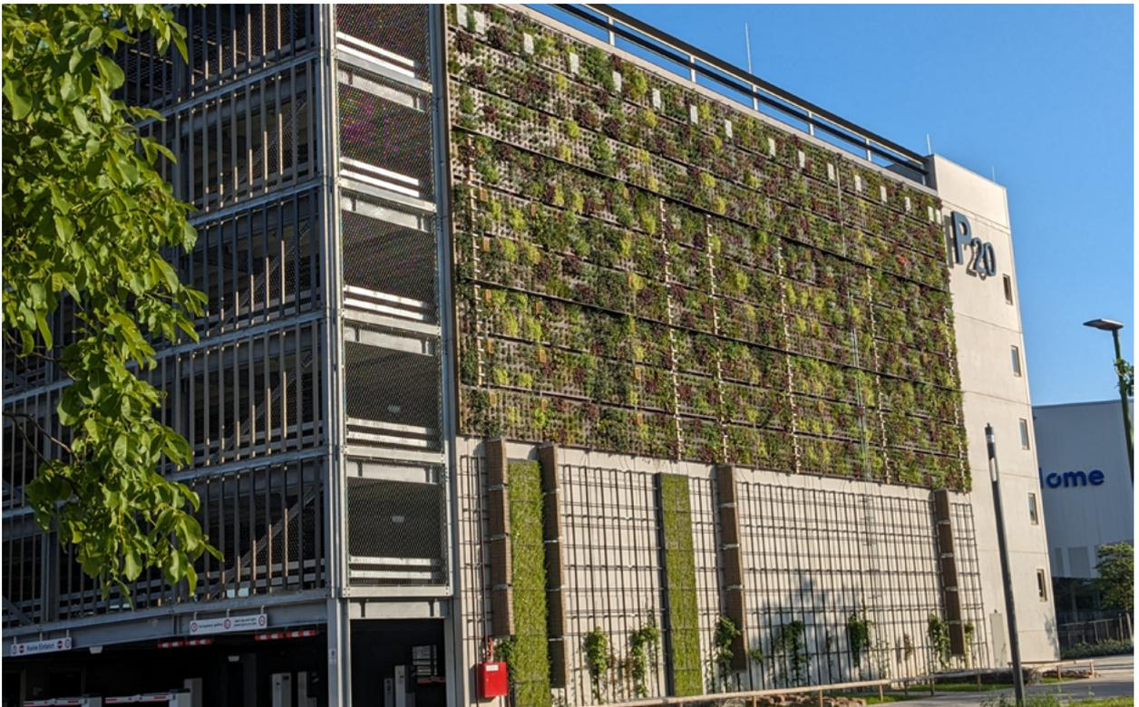
**Abbildung 39.** Die neue Fassadenbegrünung am P20-Parkhaus in Heidelberg besteht im oberen Bereich aus einer wandgebundenen Bepflanzung mit 7000 Stauden und integrierten Insekten-Nistereinheiten sowie Fledermauskästen. Im unteren Bereich wurden 32 Rankpflanzen sowie vertikale Einsaatmodule ergänzt und am Boden weitere Strukturen für Tiere geschaffen.
